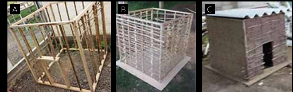
Figura 01 - Etapas do processo de construção do protótipo: A) Bambus inteiros na vertical. B) Bambus cortados e amarrados com fio de sisal na horizontal. C) Preenchimento das paredes com o solo preparado.
